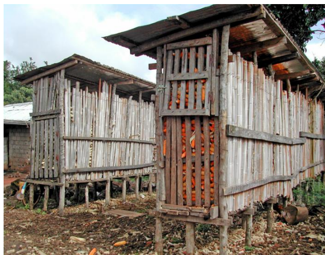
Photo 23: Mauvaises conditions de stockage du maïs
